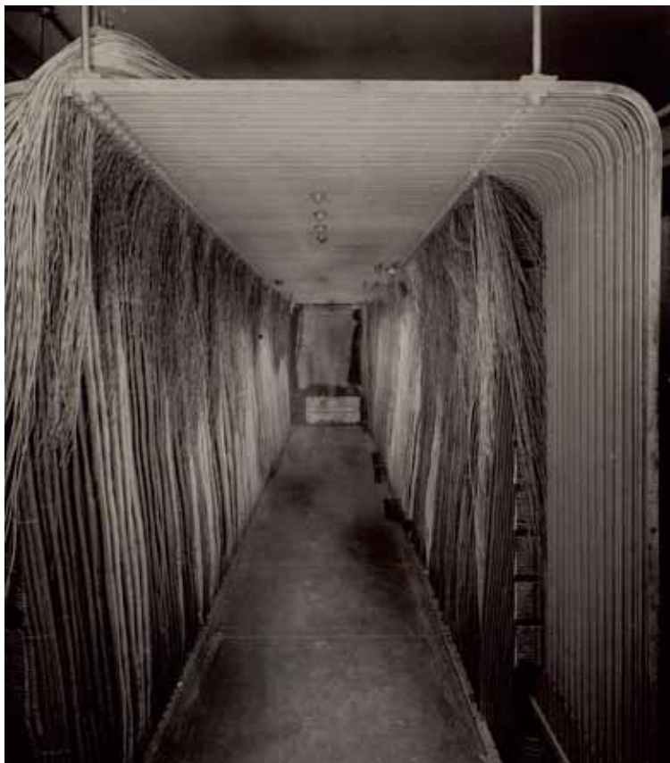
Bilden närmast t.v.: Korskopplingsplint vid telefonstationen Skeppsbron 2, Stockholm. Stationen var i drift fram till 1929.
