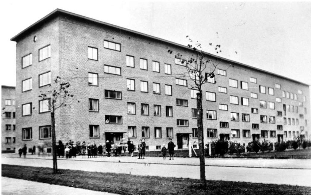
Redan 1935 fattade riksdagen beslutet att låta bygga särskilda barnrikehus som en första genomgripande åtgärd för att minska trångboddheten. Husen var till för "mindre bemedlade" barnrika familjer. Barnrikehus i Malmö 1937.
